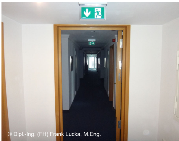
Hinterleuchtetes Sicherheitszeichen für Rettungswege nach DIN EN 1838:2019-11
