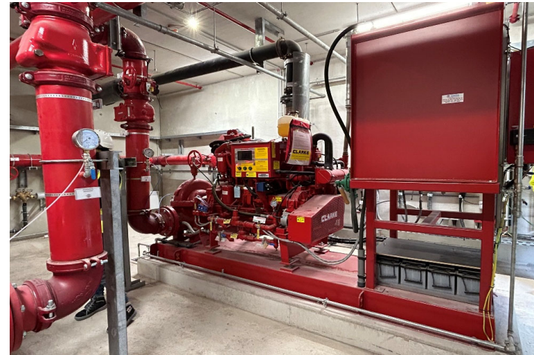
Dieselmotor als Pumpenanlage
