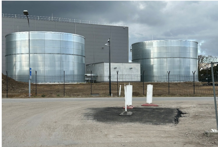
Sprinklerzentrale und Sprinklertank
